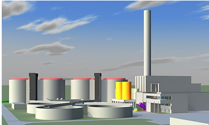
Schlammwässerungs- und Verbrennungsanlage (SEVA) mit Faulungsanlage und Gasverwertung
